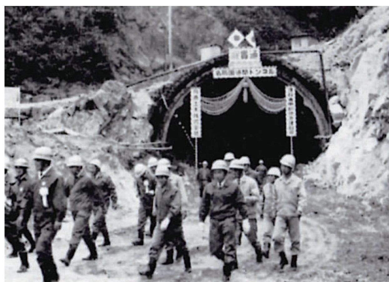
関トンネル貫通(1964)
