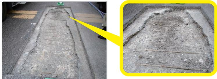
亀山大橋(上り:50歳)／床版下面の損傷(剥離・鉄筋露出)
