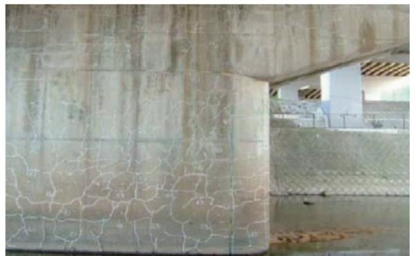
アルカリ骨材反応によりひび割れや鋼材の露出が発生
