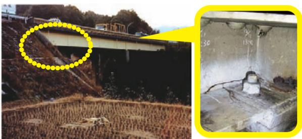
越川大橋(下り:43歳)／床版上面の損傷(土砂化)
