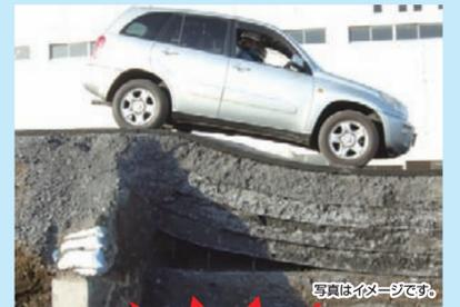
揺すり込み沈下が発生しても段差にならず通行が可能
