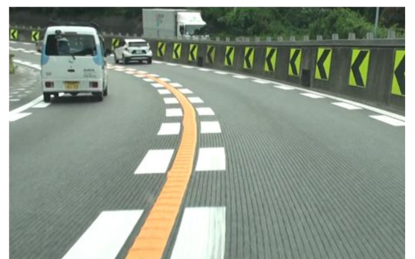
車線変更抑制対策（リブ付き高輝度ライン）
