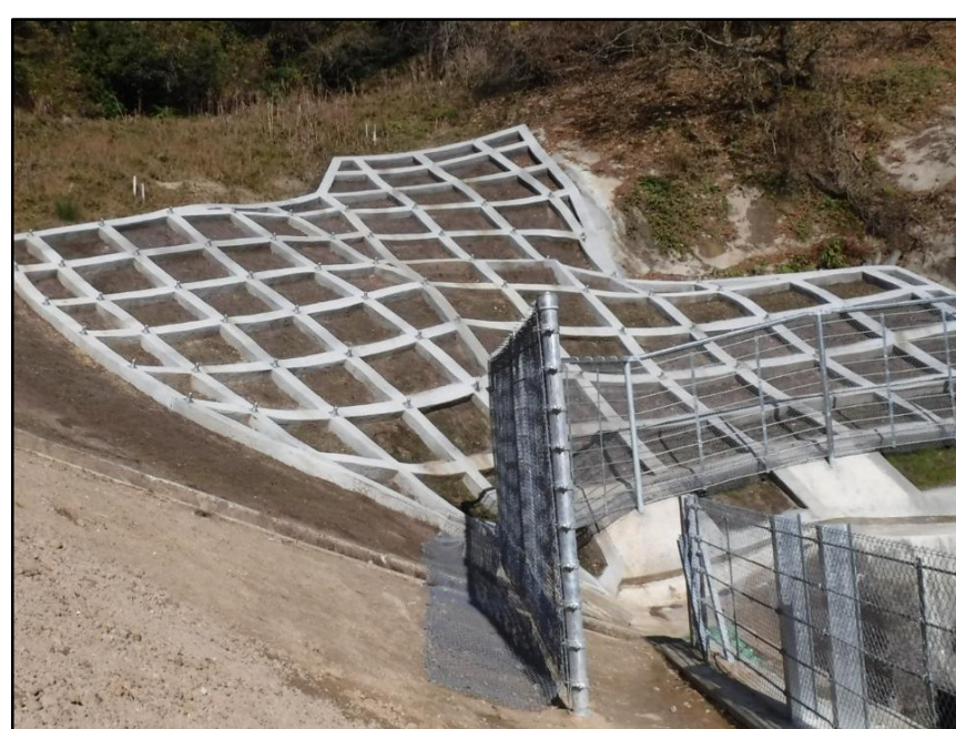
法面崩壊及び落石対策
