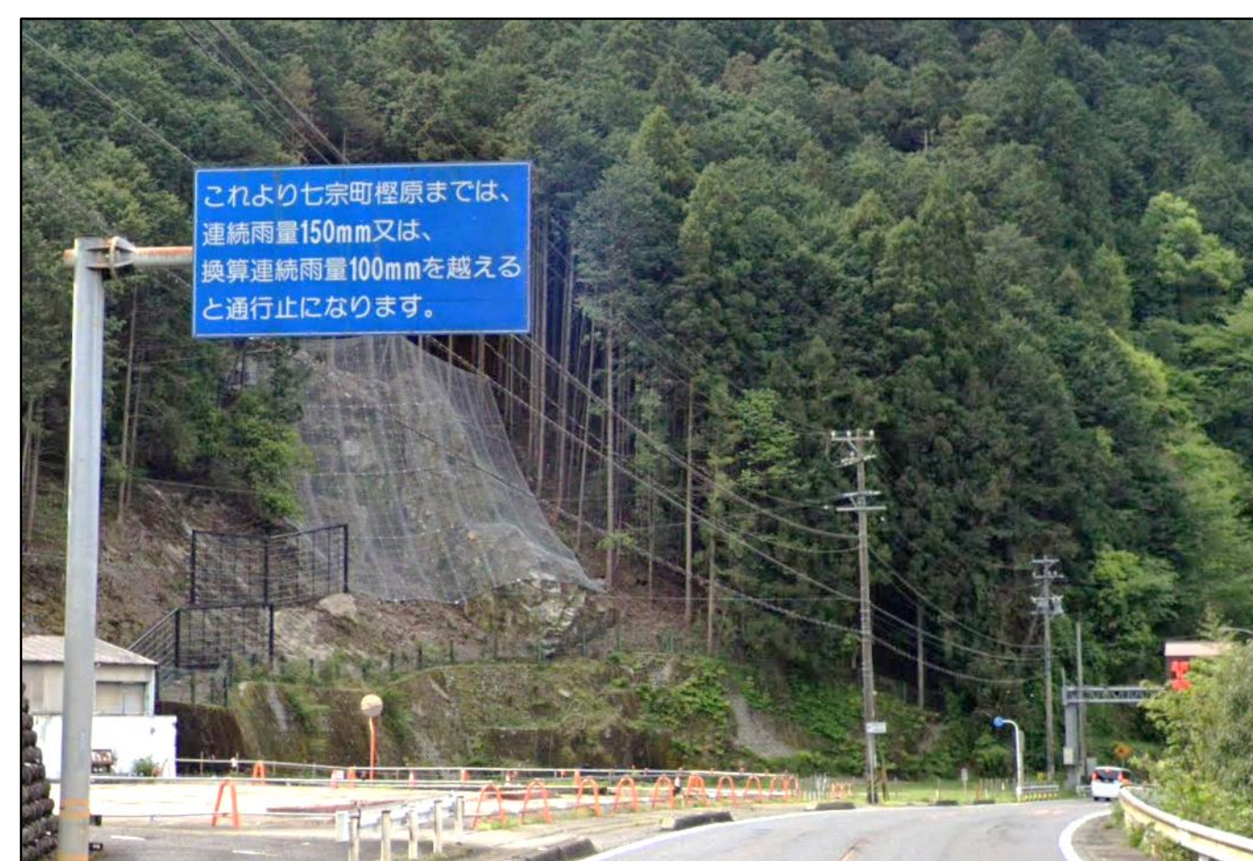
国道41号_雨量による通行止めの予告看板
