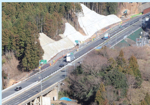
久我IC改良工事(工事状況写真)
