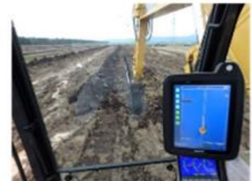
ICTバックホウによる暗渠排水掘削
