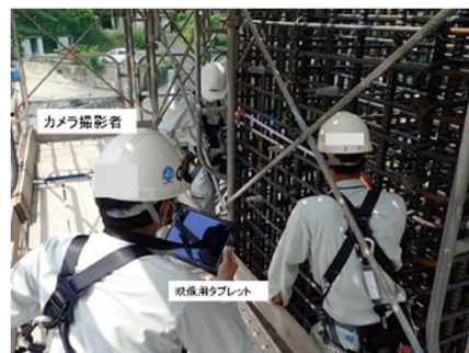
①臨場（受注者）の状況
