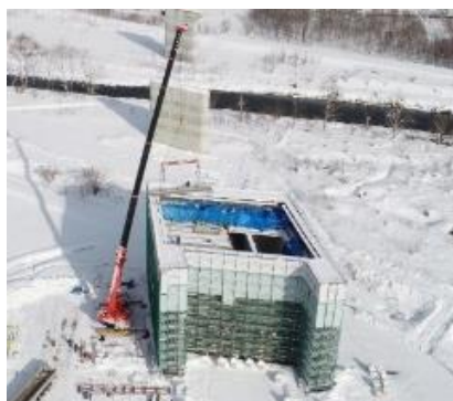
プレキャスト部材の活用
