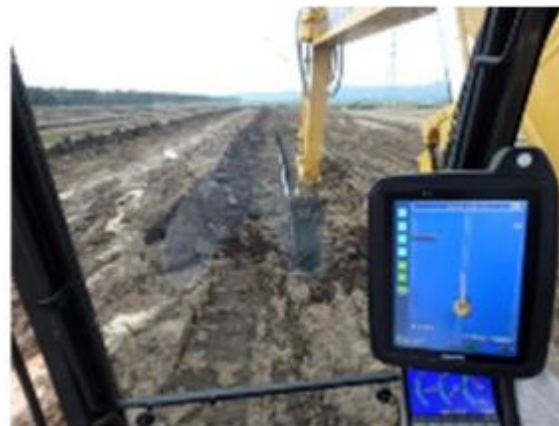
ICTバックホウによる暗渠排水掘削
