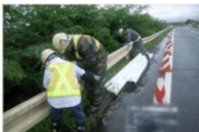
＜防護柵の取替＞
