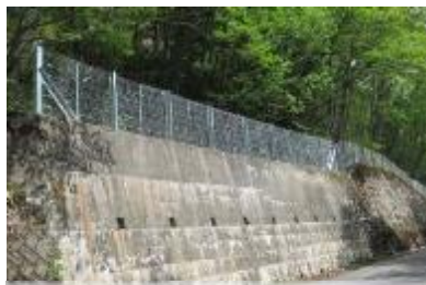
＜落石防止柵の取替＞
