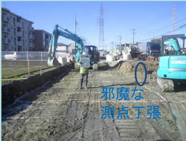
従来施工では、丁張りが必要となるが、施工時には支障となる。糸下がりの基準高管理にも手下作業員が必要となる。夕方から夜間にかけての掘削時の糸下がりによる基準高管理は、見にくくなり作業効率が落ちる。
