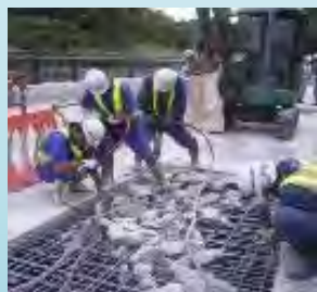
▲修繕・耐震補強
