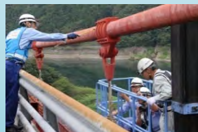
▲国道メンテナンス
