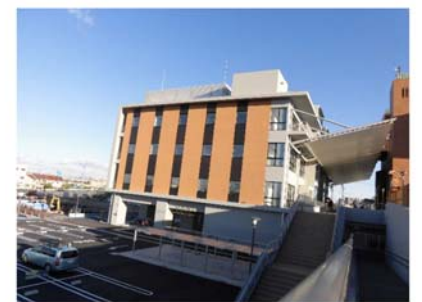
清須市本庁舎増築棟完成後全景
