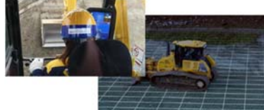
ICT建機による施工
