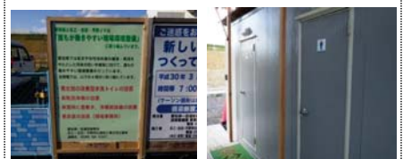
(下図)H28工事における看板・男女別改善型仮設トイレ設置事例
