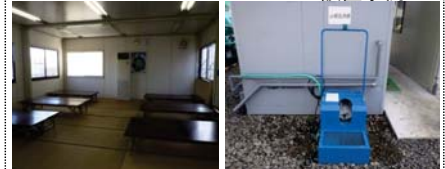
(下図)H28工事における休憩所・長靴洗浄機設置事例
