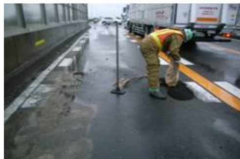
道路損傷の補修
