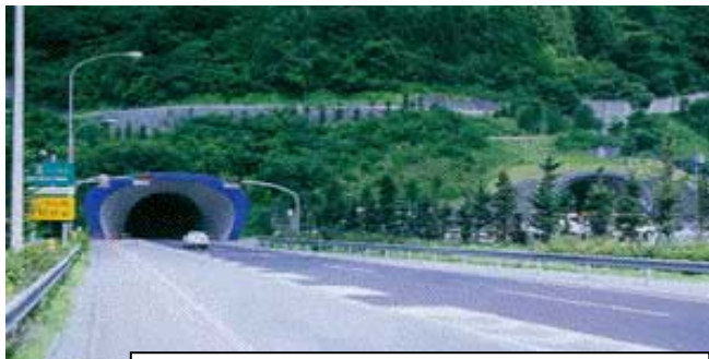
長大トンネル
