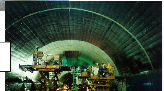
高性能連続強化繊維シート によるコンクリート補強
