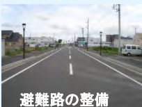
避難路の整備
