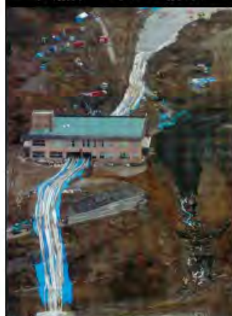
天然ダムポンプ排水
