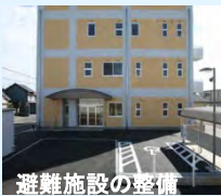
避難施設の整備
