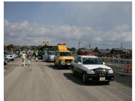
【道路啓開訓練】(津市)
