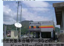
【防災拠点施設】
