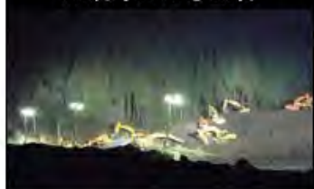
照明車による照明
