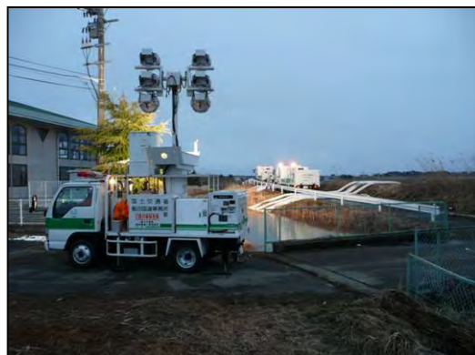
津波被害における排水作業 (石巻市)
