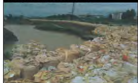
堤防決壊部応急仮締切
