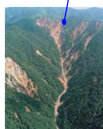
いちのさわ 一の沢崩壊地
