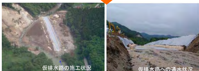
仮排水路の施工状況
