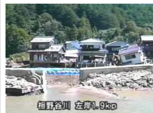
新宮川水系相野谷川高岡地区の輪中堤転倒状況
