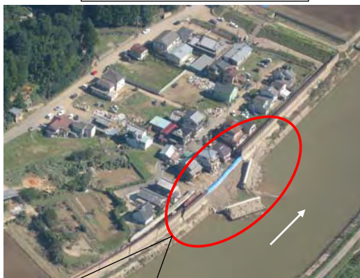
台風12号による被害
