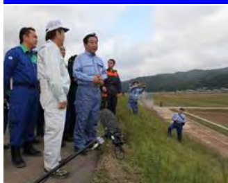
紀宝町大里地区の浸水被害を堤防上より視察する野田総理
