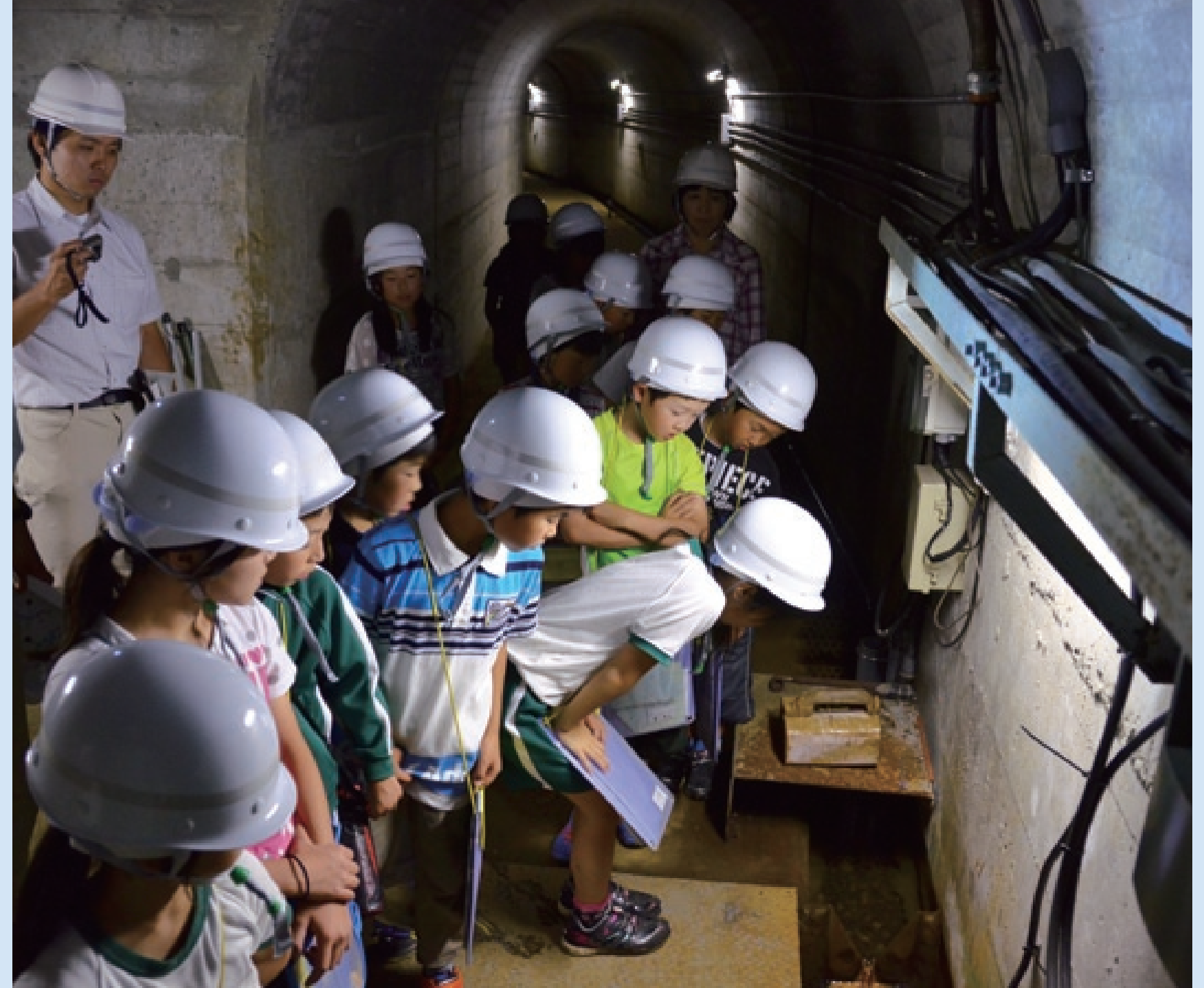
ていたない 堤体内の見学
