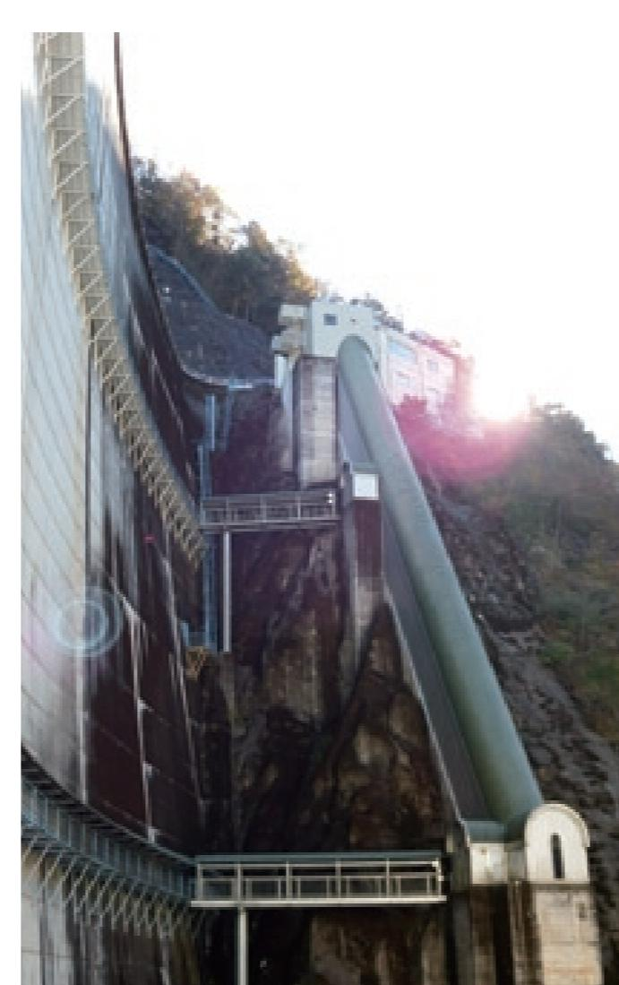
山の形状に沿って斜めに動くエレベータ。台風時などにも安全にコンジットゲートに行くためにダム完成後に整備されました。
