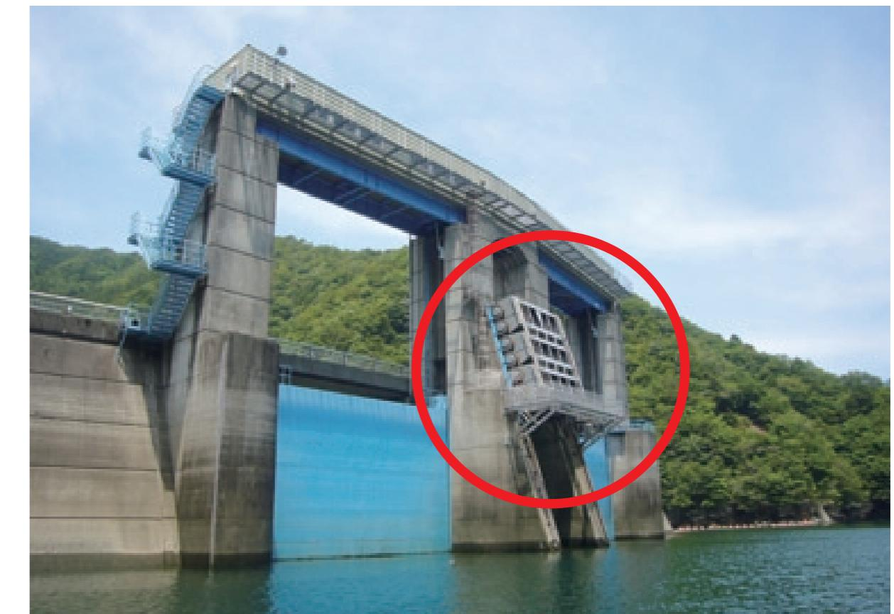
普段は全閉から数mの位置に固定してあり、コンジットゲート点検時、コンジットゲートを閉める際に不具合が生じたときに操作するゲート。(点検中写真)
