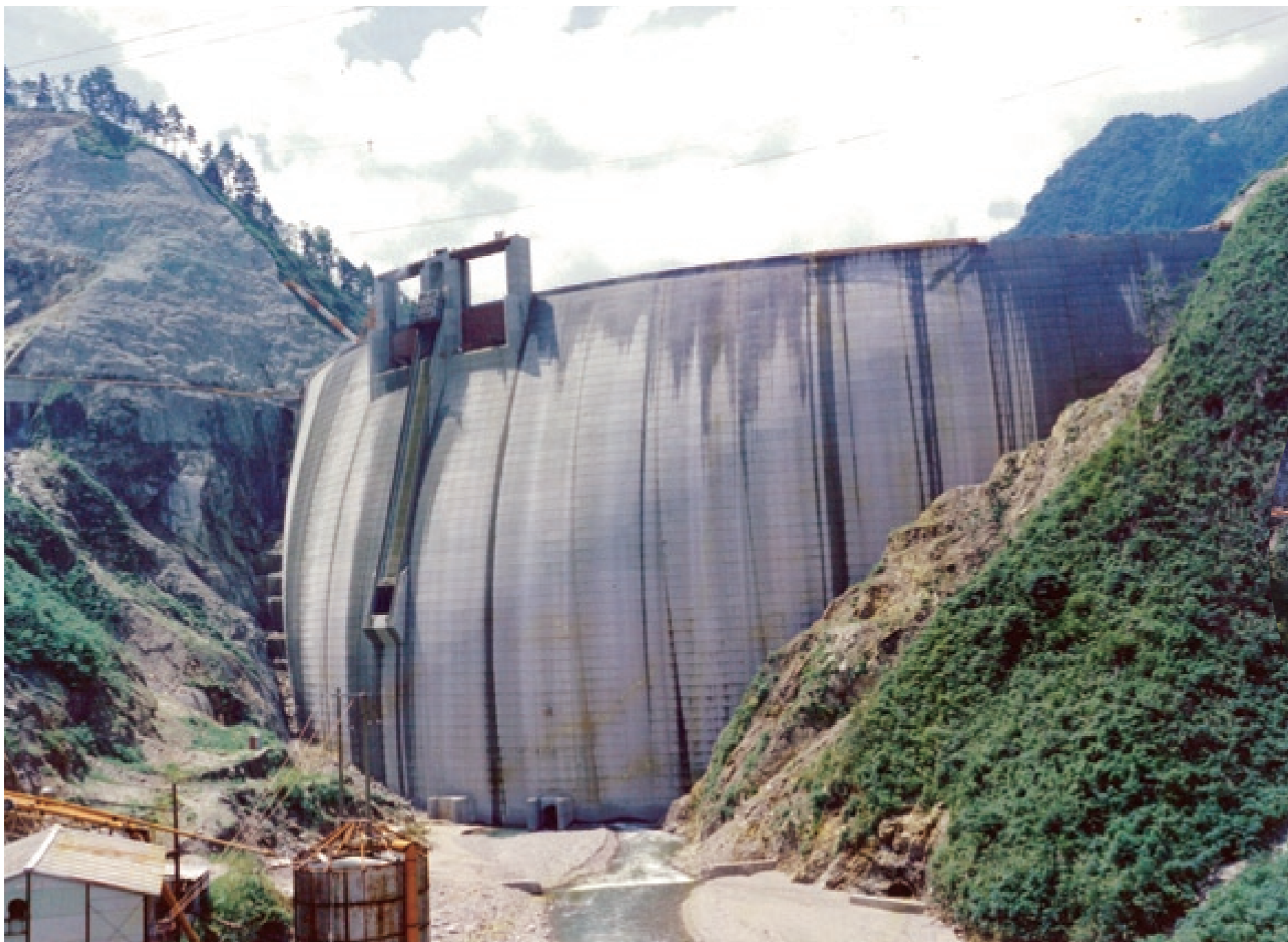
上流側からみた本体打設完了後の様子(S47.9)
