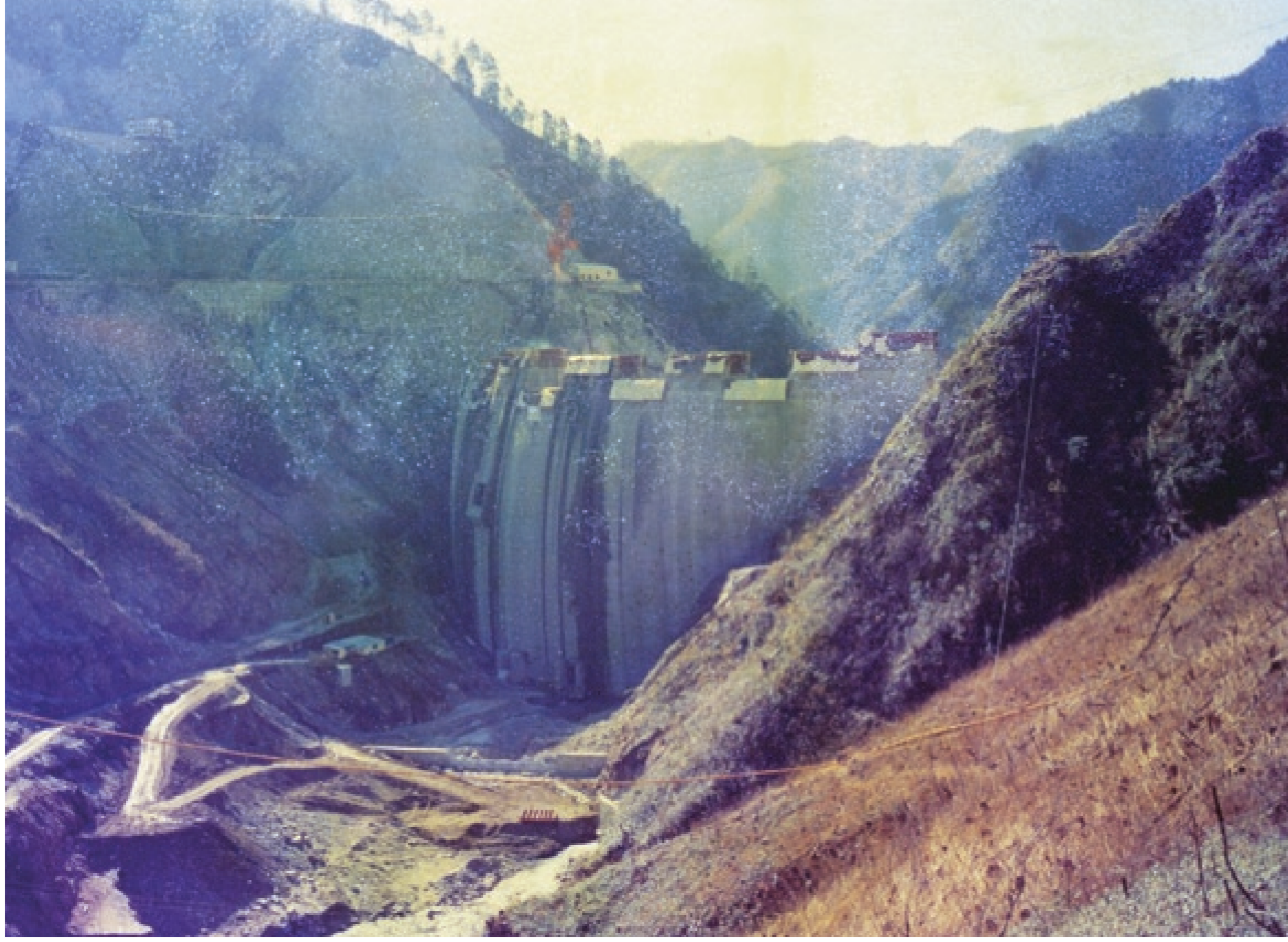
上流側からみた本体打設中の様子(S47.1)
