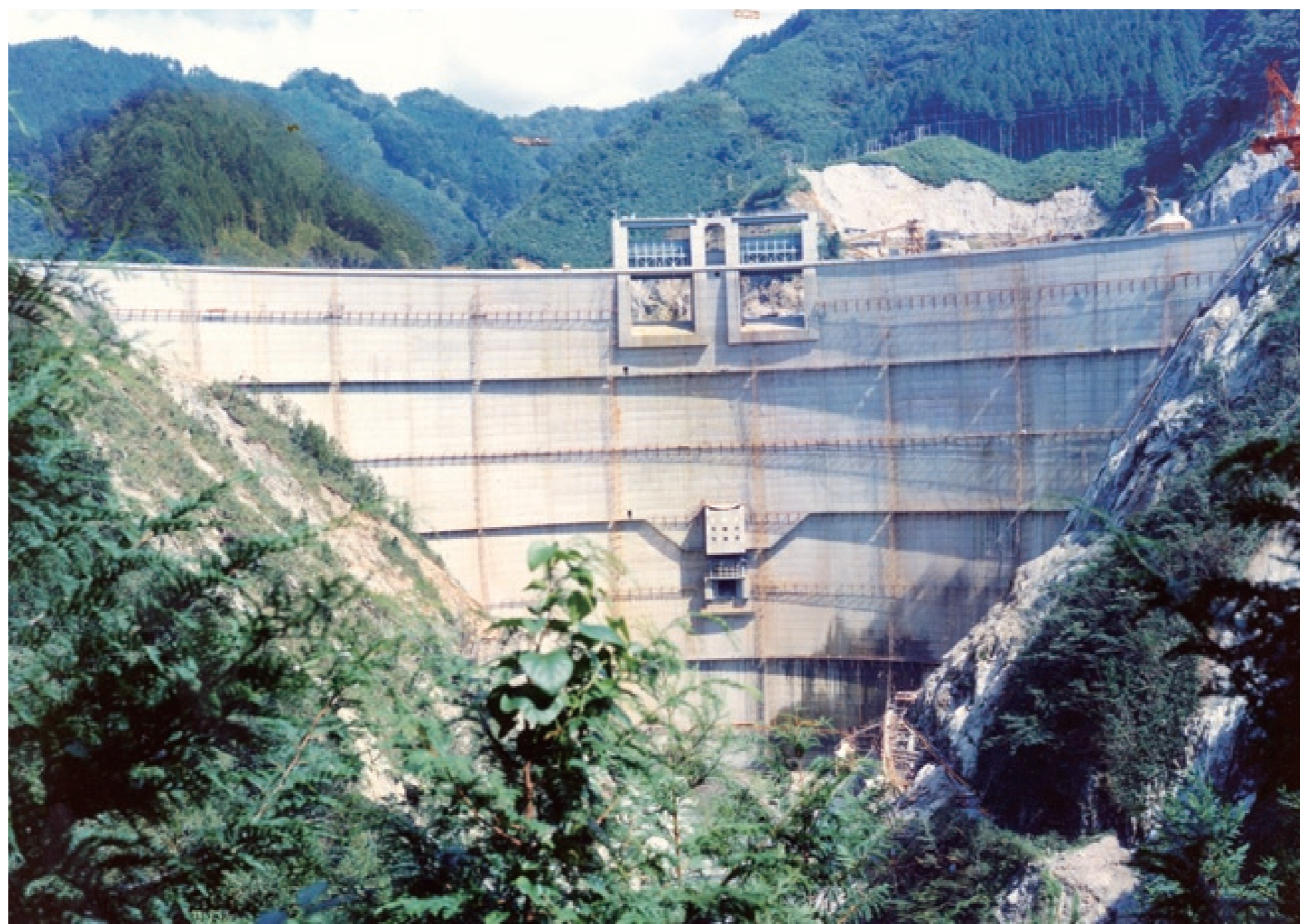
下流側からみた本体打設完了後の様子(S47.9)
