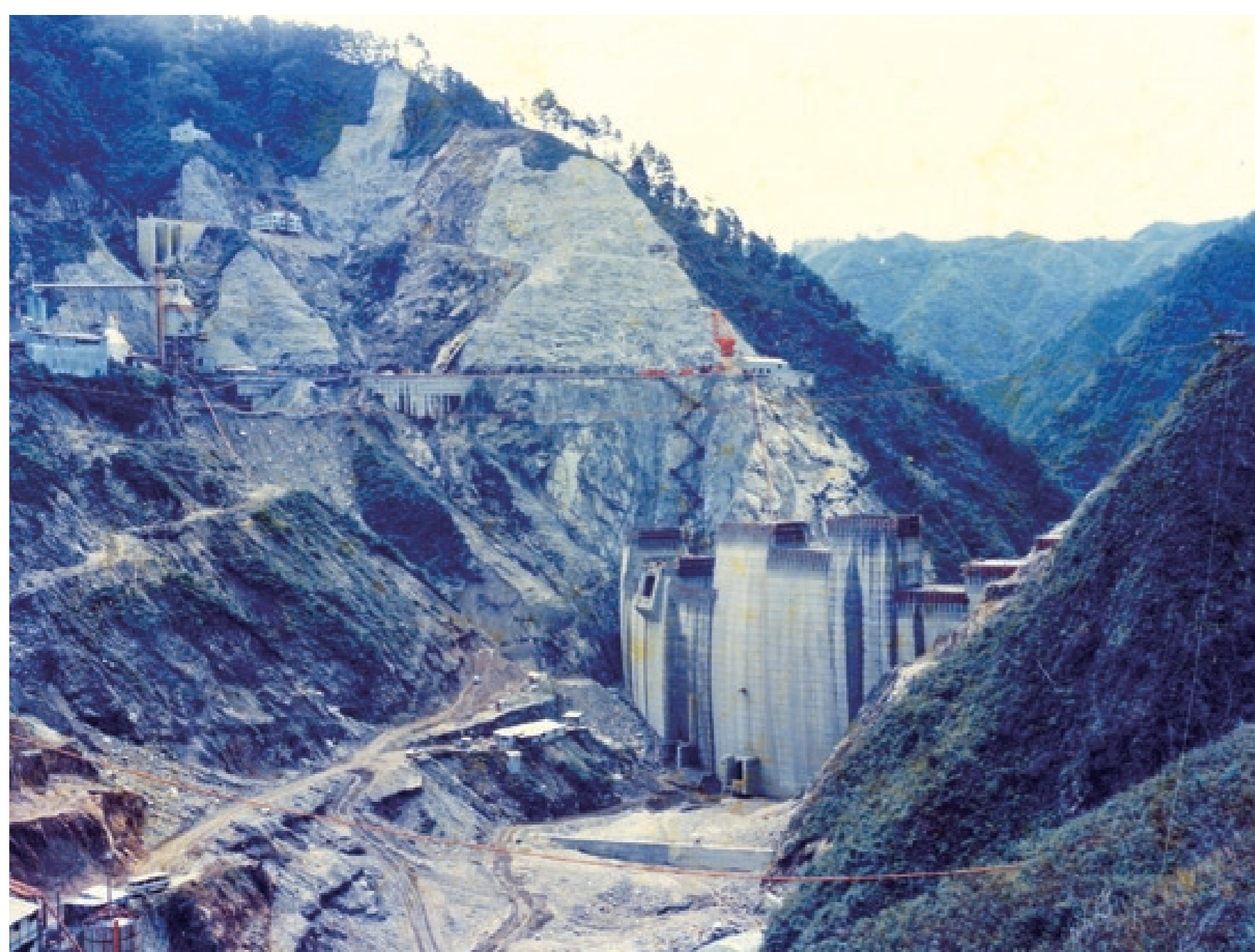
上流側からみた本体打設中の様子 (S46.10)
