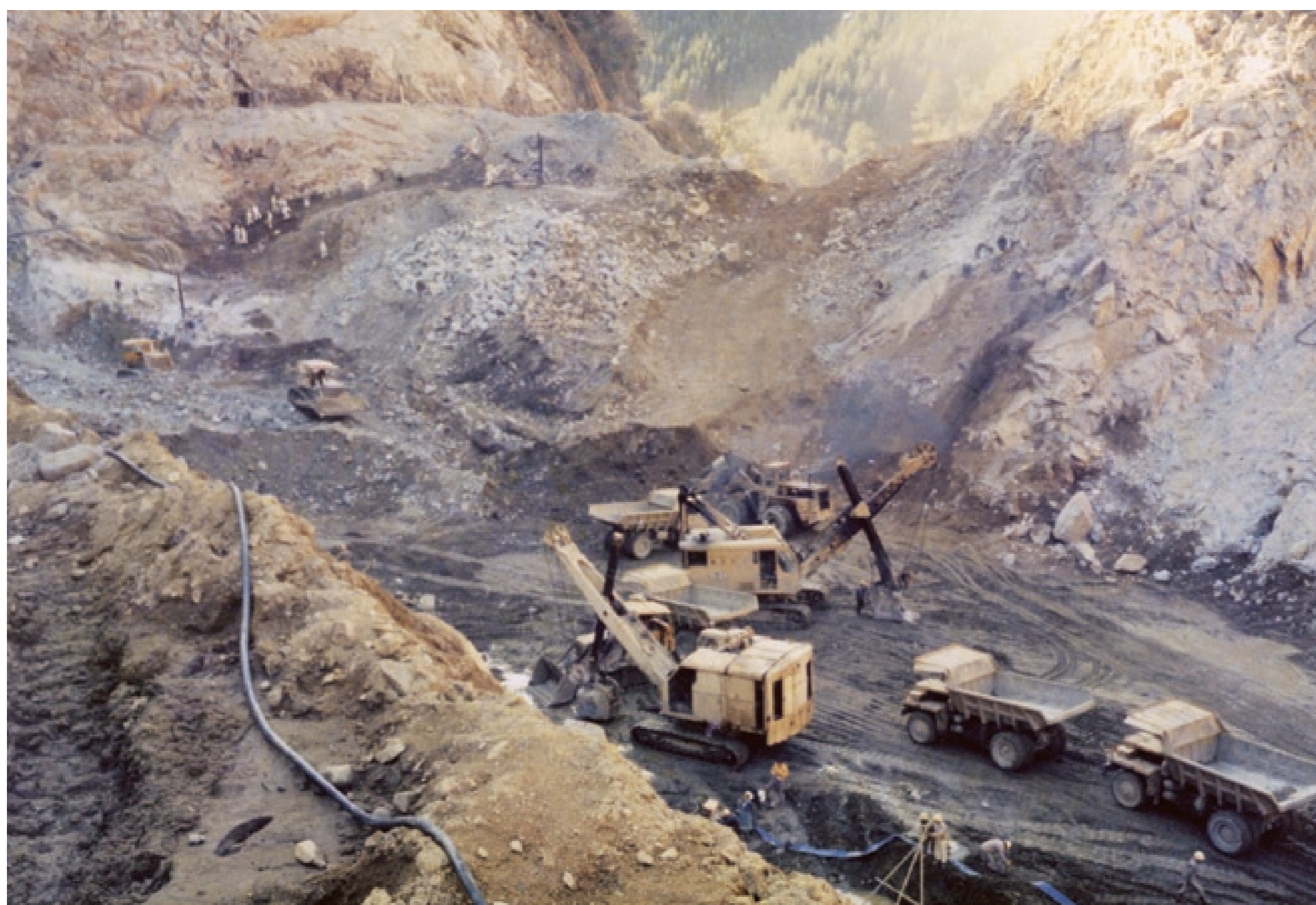
使用された重機 (S45.12)
