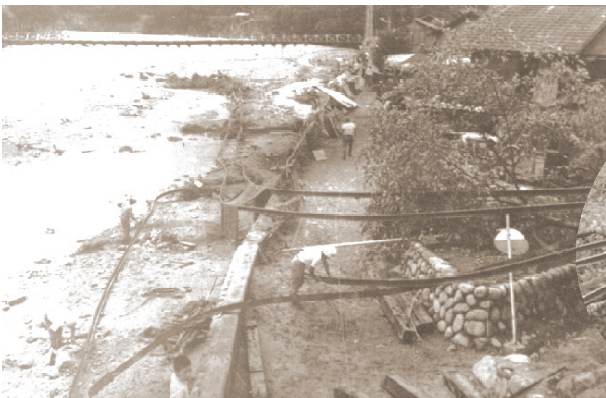
洪水で曲げられた旧国鉄飯田線鉄橋部分のレール(大千瀬川)
