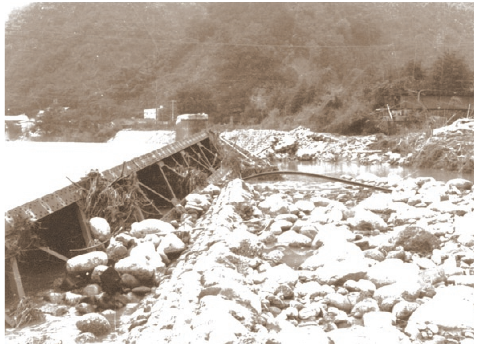
流出した旧国鉄飯田線鉄橋(大千瀬川)
