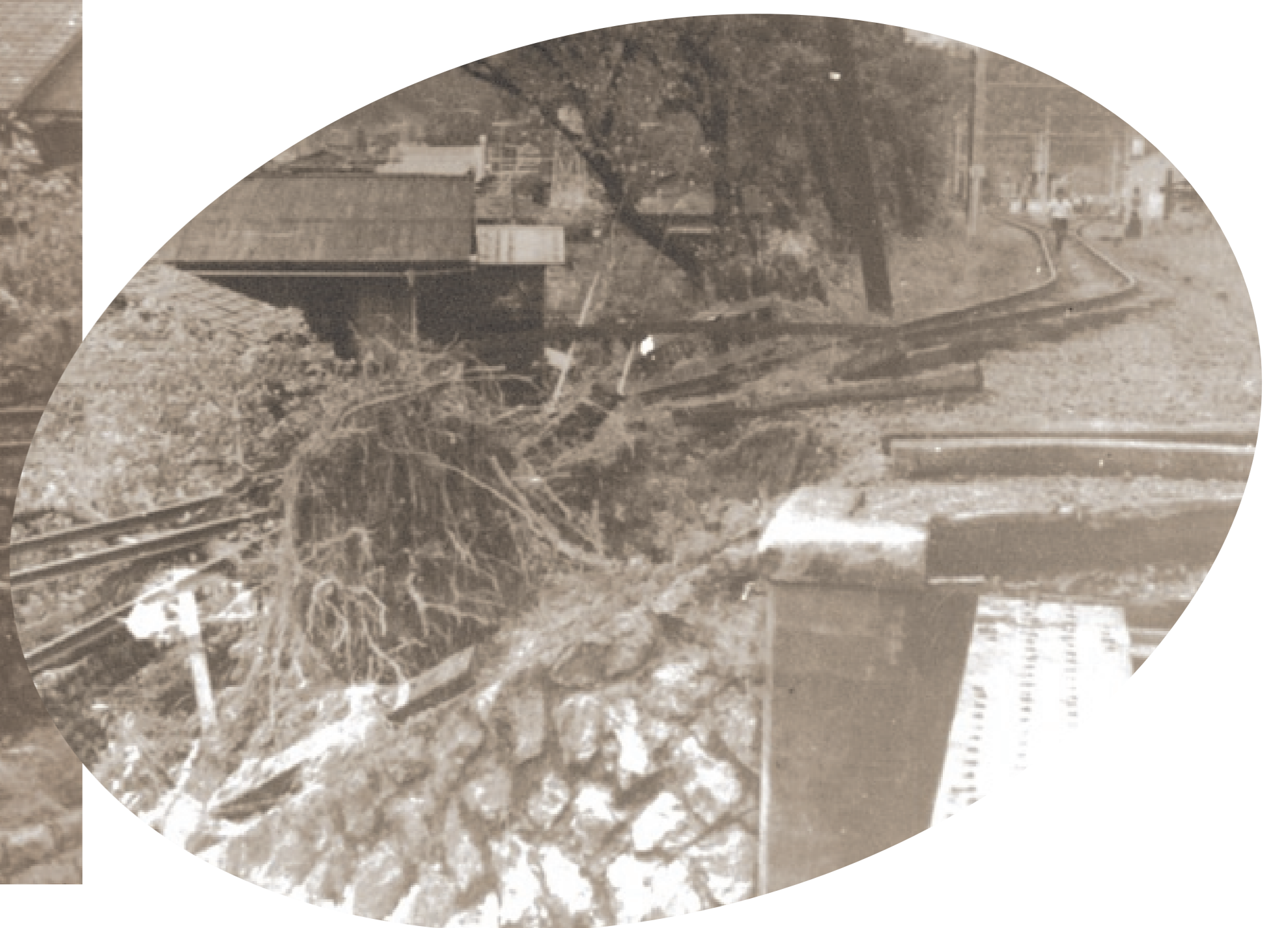
流出した旧国鉄飯田線鉄橋(大千瀬川)
