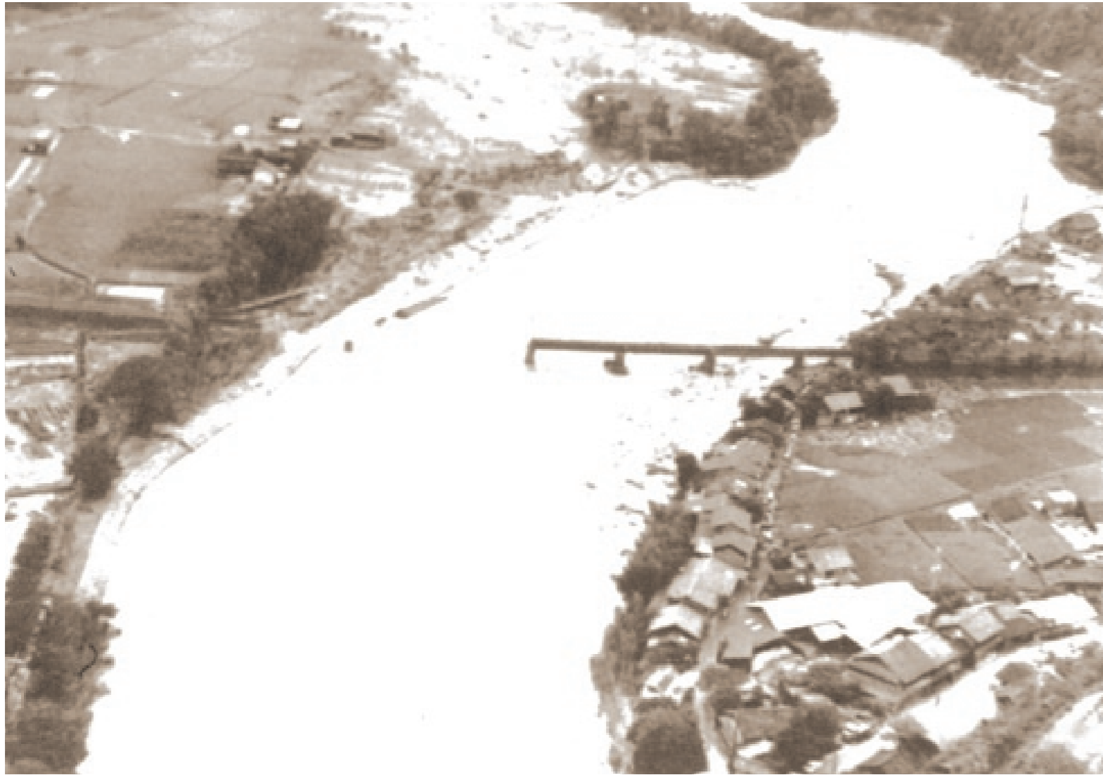
増水により一部流出した旧国鉄飯田線の鉄橋(大千瀬川)
