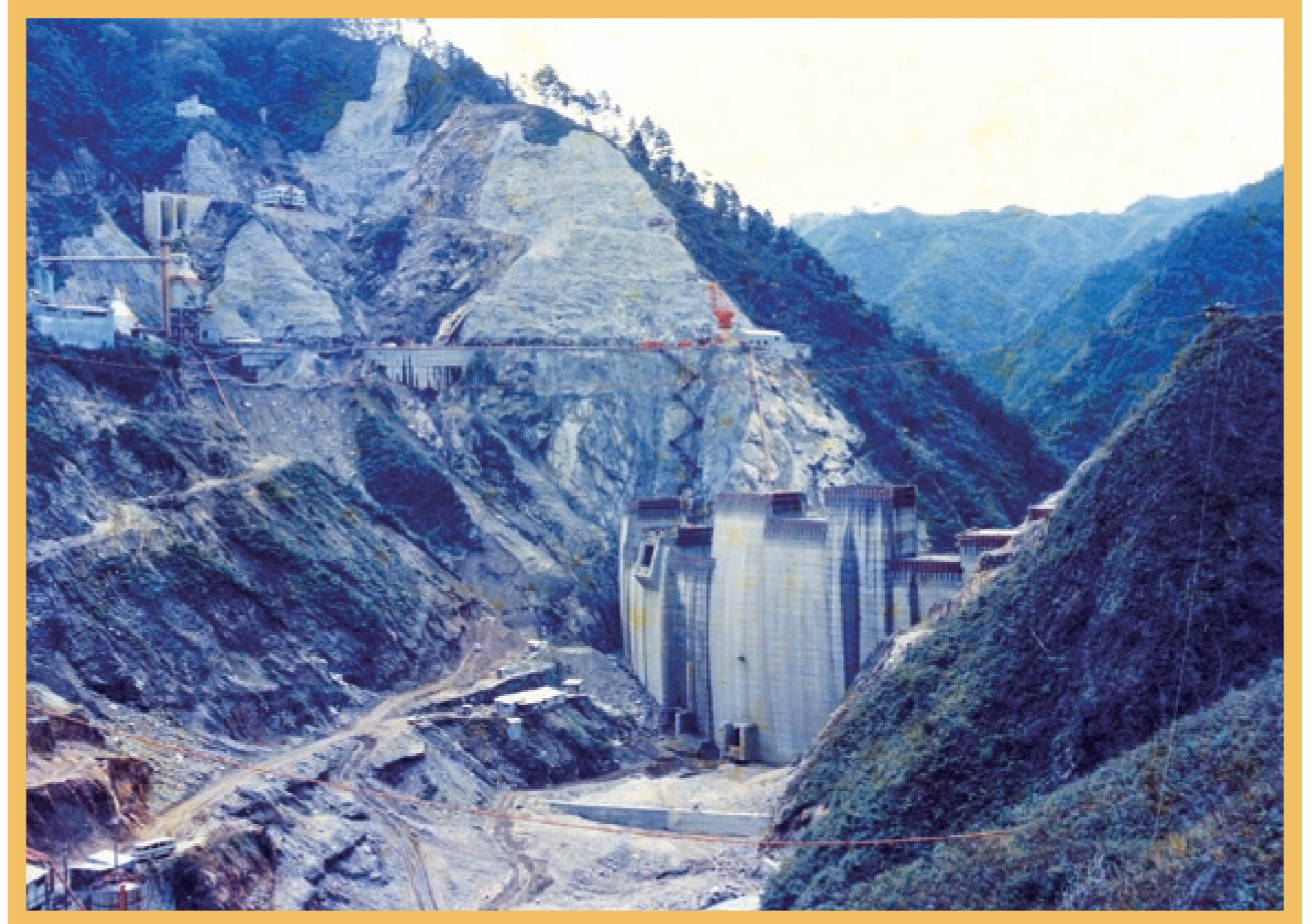
上流側から見た本体打設中の様子(S46.10)
