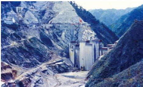
上流側から見た本体打設中の様子 (S46.10)
