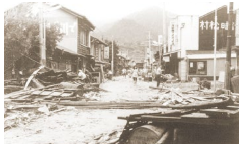
昭和43年台風第10号による旧佐久間町浦川地区の様子
