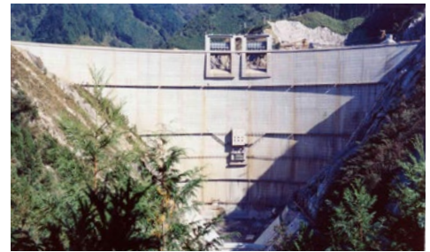
下流側からみた本体打設完了後の様子 (S47.9)
