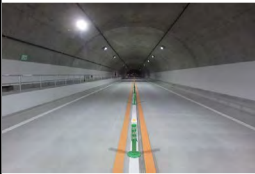
舗装工事(完成)
