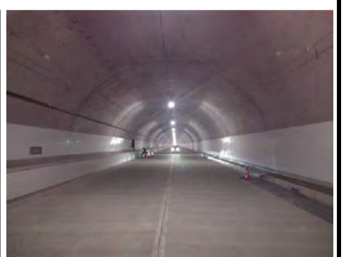
内装板設置状況
