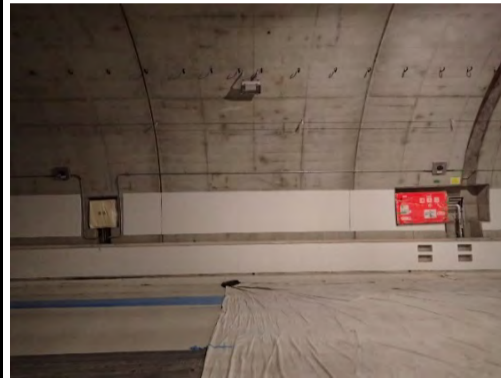
トンネル内機器
