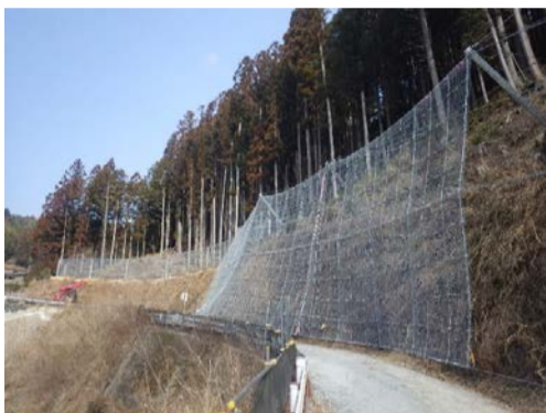
落石対策工事
