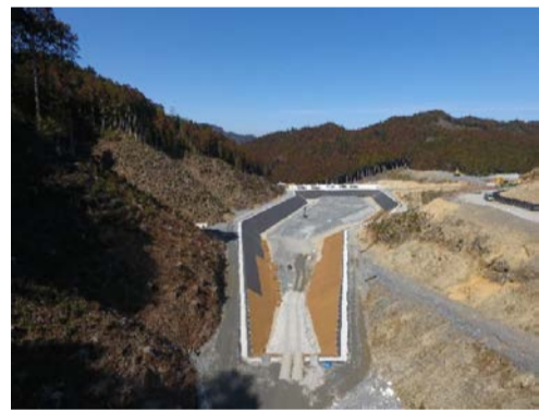
要対策土処理場(背面から)
