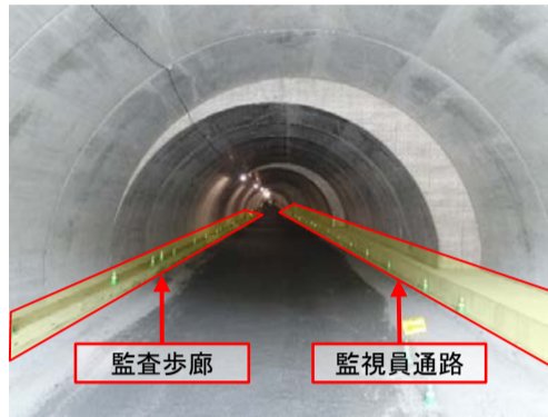
トンネル内監査路施工完了
