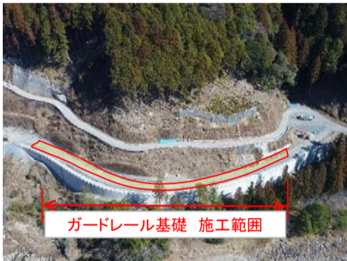
ガードレール基礎
