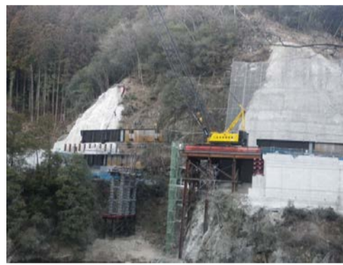
第1回 桁架設状況
