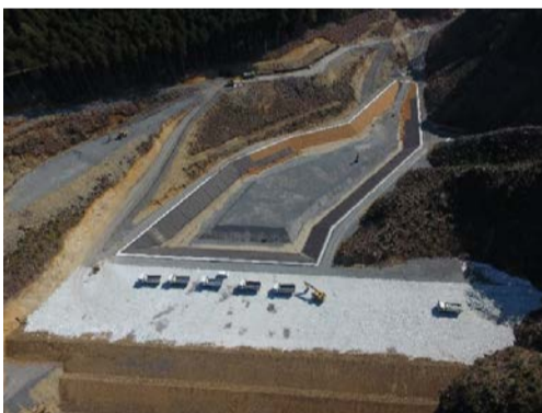
要対策土処理場(前面から)
