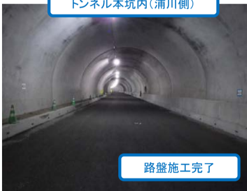
トンネル本坑内(浦川側)
