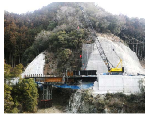
第2回 桁架設状況
