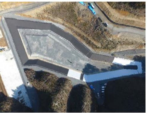
遮水シート施工状況(上空から)
