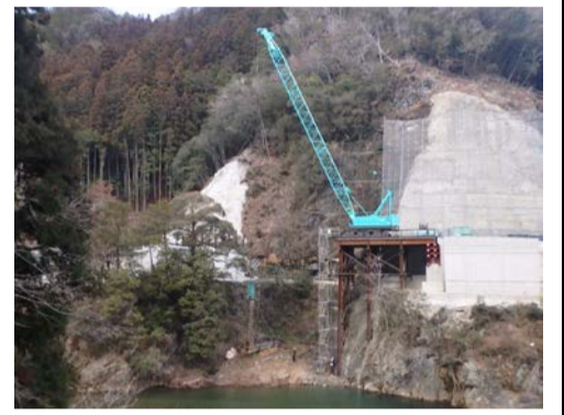
基礎杭削孔状況
