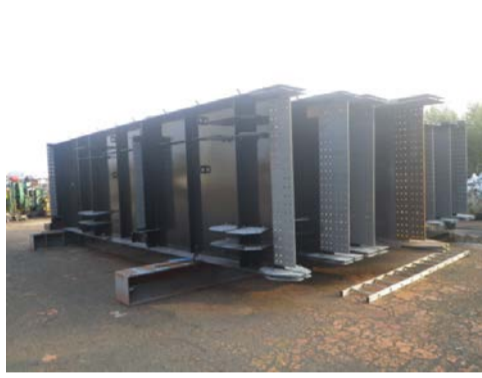
橋桁製作(塗装完了)
