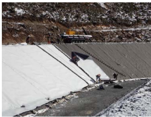
遮水シート施工状況
