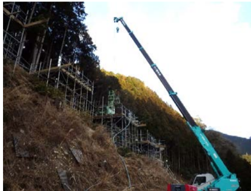
落石対策工事
