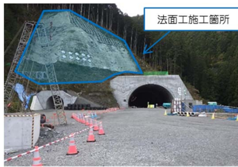
法面施工エリア
