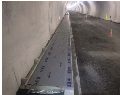
監査路上のコンクリート舗装施工完了
