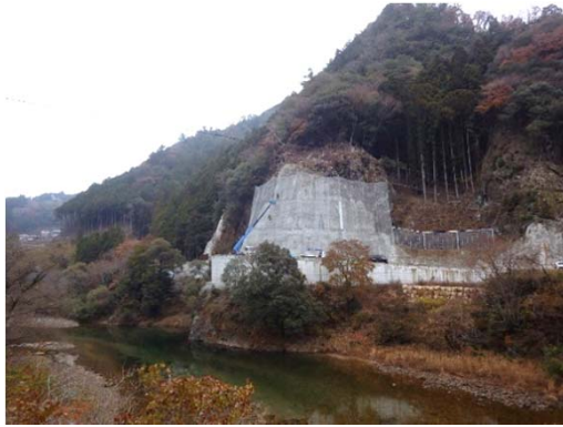
落石対策工事
