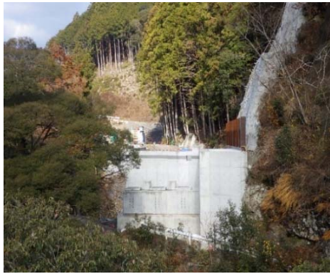
橋台工施工完了
