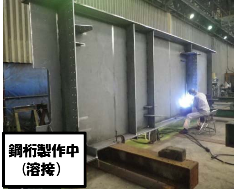
鋼桁製作中(溶接)
