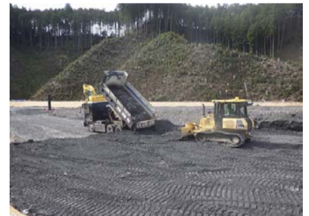
盛土施工状況
