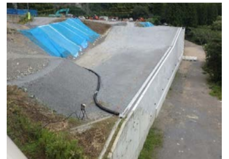
補強土壁全景
