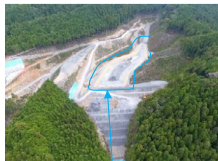
対策土盛土箇所
