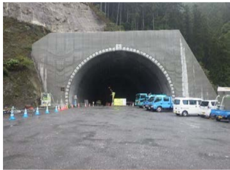
トンネル坑口部
