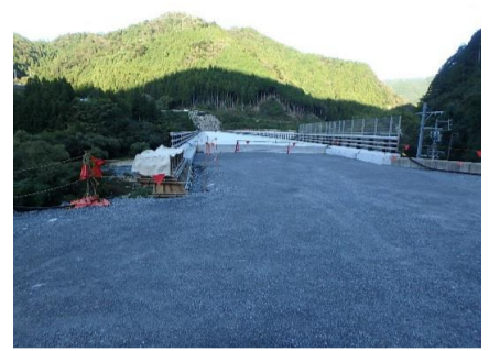
4号重力式擁壁
