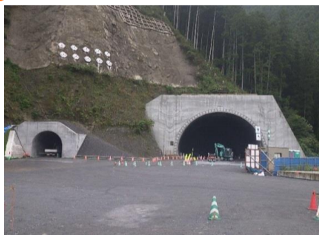
トンネル坑口部
