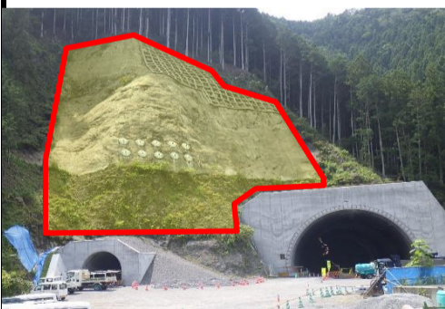
法面施工エリア
