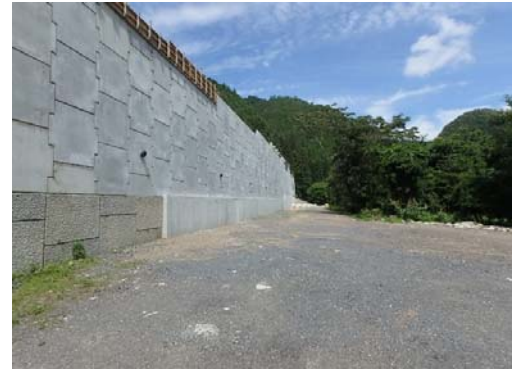
補強土壁 (下流側から撮影)
