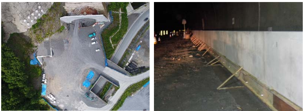
トンネル坑口部(空撮)
