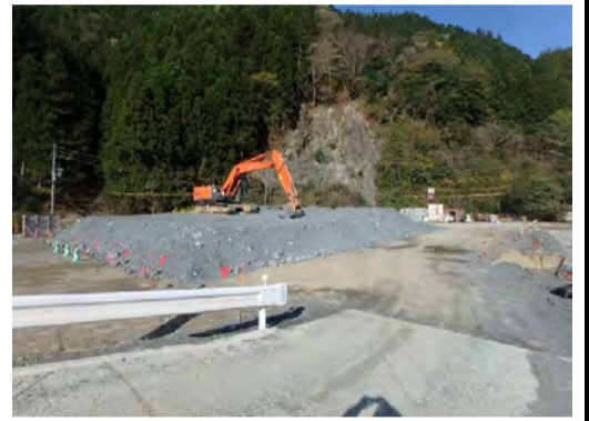
盛土材の搬入
