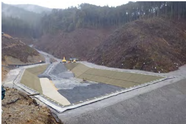
対策土受入ヤード
