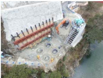
A1橋台施工箇所
