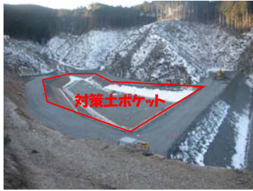
対策土受入ヤード
