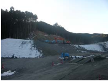
普通土仮置きヤード
