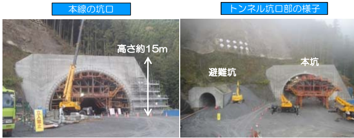
本線の坑口 (高さ約15m) / トンネル坑口部の様子 (避難坑、本坑)
