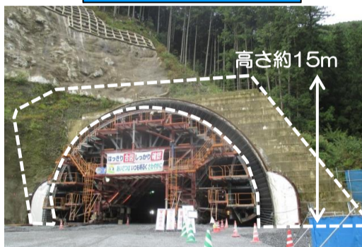
トンネル坑口部の様子
