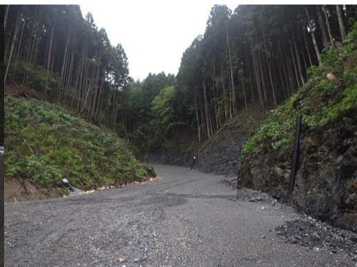
排水管布設完了
