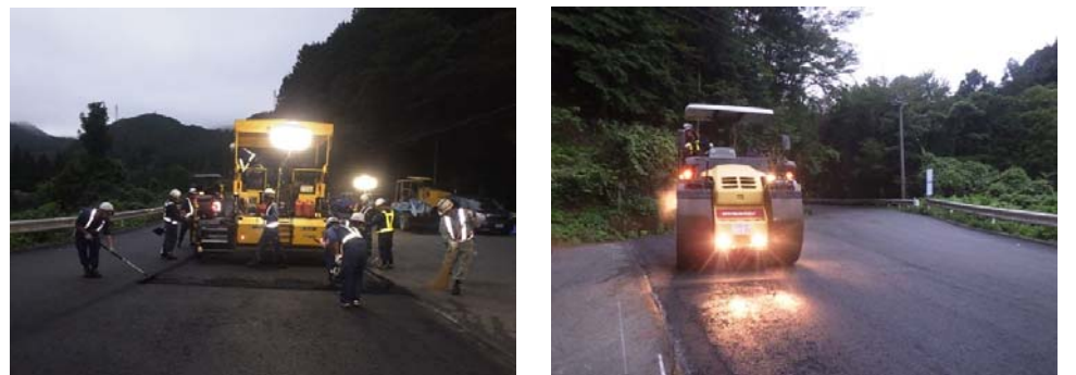
【合材敷き均し状況】
