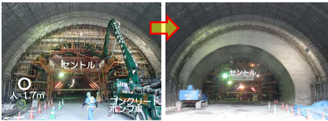
坑口部のコンクリート巻立て作業の様子
