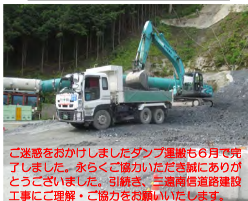
トンネル掘削残土の運搬の様子
