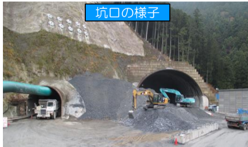
本坑坑口部の施工の様子 インバート(トンネルの底の部分)にコンクリートを打設しています。
