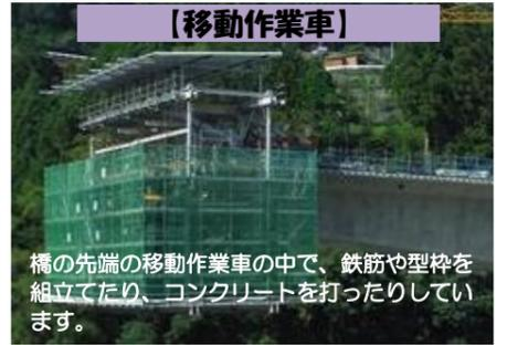
橋の先端の移動作業車の中で、鉄筋や型枠を組立てたり、コンクリートを打ったりしています。
