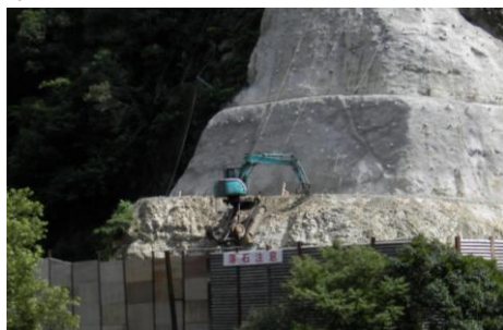
RCMによる施工状況
