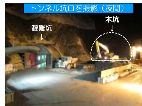
日夜、大型重機が稼働してトンネルを掘削しています。右側はローディングショベルとって少し珍しい機械です。
