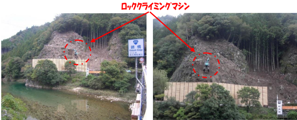
【大千瀬川下流錦橋より左岸側を望む】
