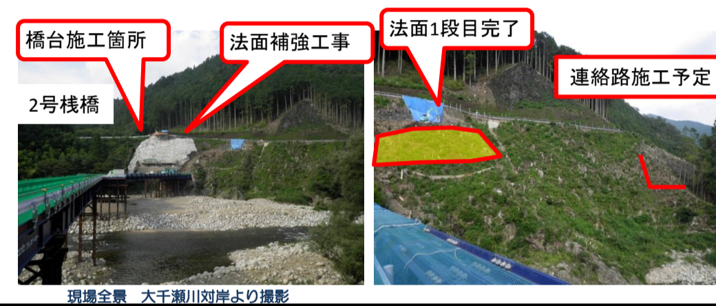
現場全景 大千瀬川対岸より撮影
