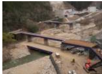
大千瀬川左岸下流より
