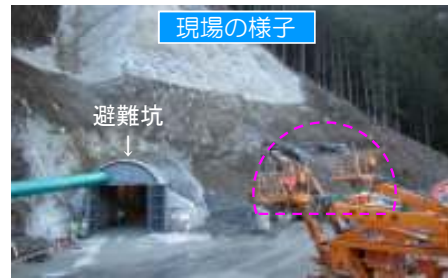
対岸からトンネル坑口を撮影
