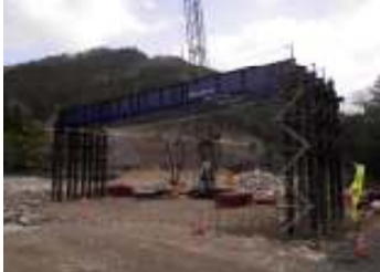
大千瀬川右岸上流より
