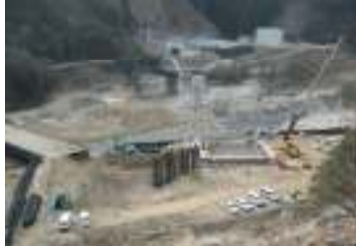
大千瀬川左岸下流より
