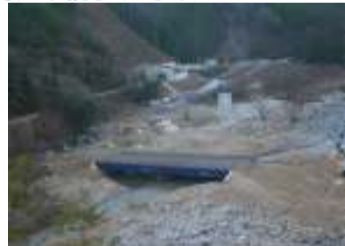
[着手前] 大千瀬川左岸下流より
