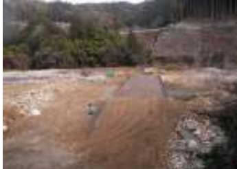
[着手前] 大千瀬川右岸下流より
