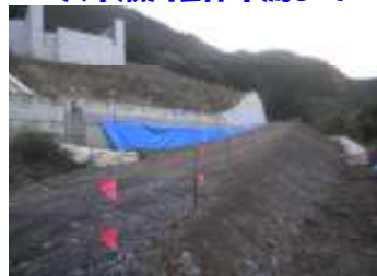
大千瀬川右岸下流より
