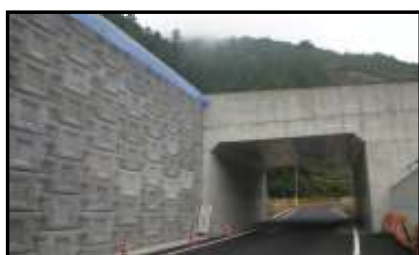
473号線の2つのボックスカルバートの間に施工している補強土壁は仕上がりが高さまで上がりました。
