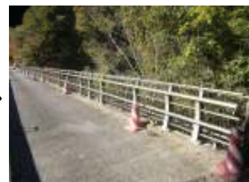
【施工中】車両防護柵を望む
