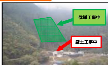
現場全景 大千瀬川対岸より撮影
