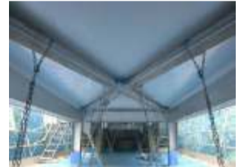
【完成】仕上げ材完了
