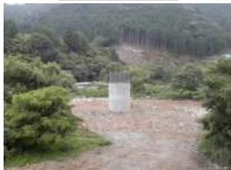
右岸側から見た現
