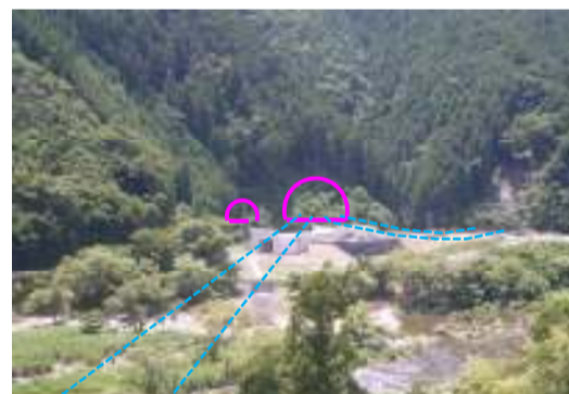
対岸からトンネル坑口を撮影
