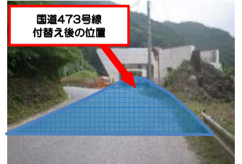
473号線付替箇所(浦川側)の様子
