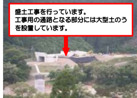
現場全景 大千瀬川対岸より撮影
